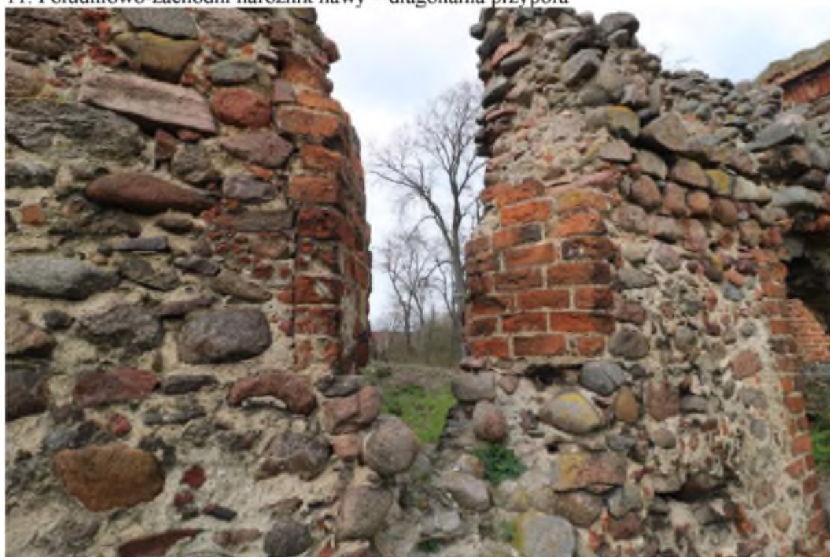
12. Południowa ściana nawy – pozostałości otworu okiennego
