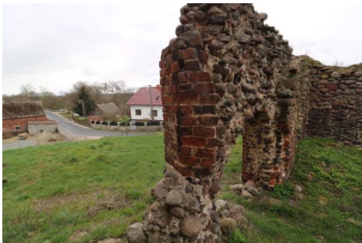
15. Południowa ściana nawy – pozostałości ościeża otworu okiennego
