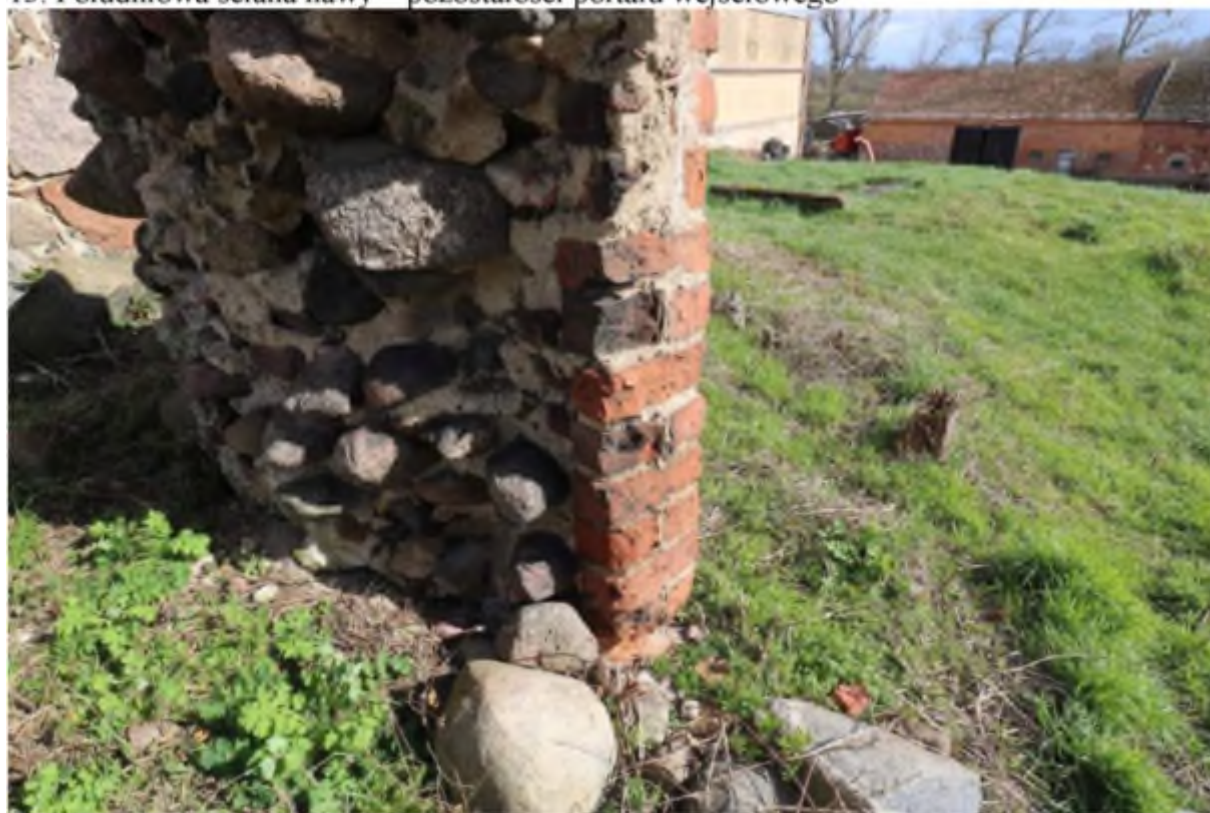
14. Południowa ściana nawy – ścięte ościeże otworu wejściowego
