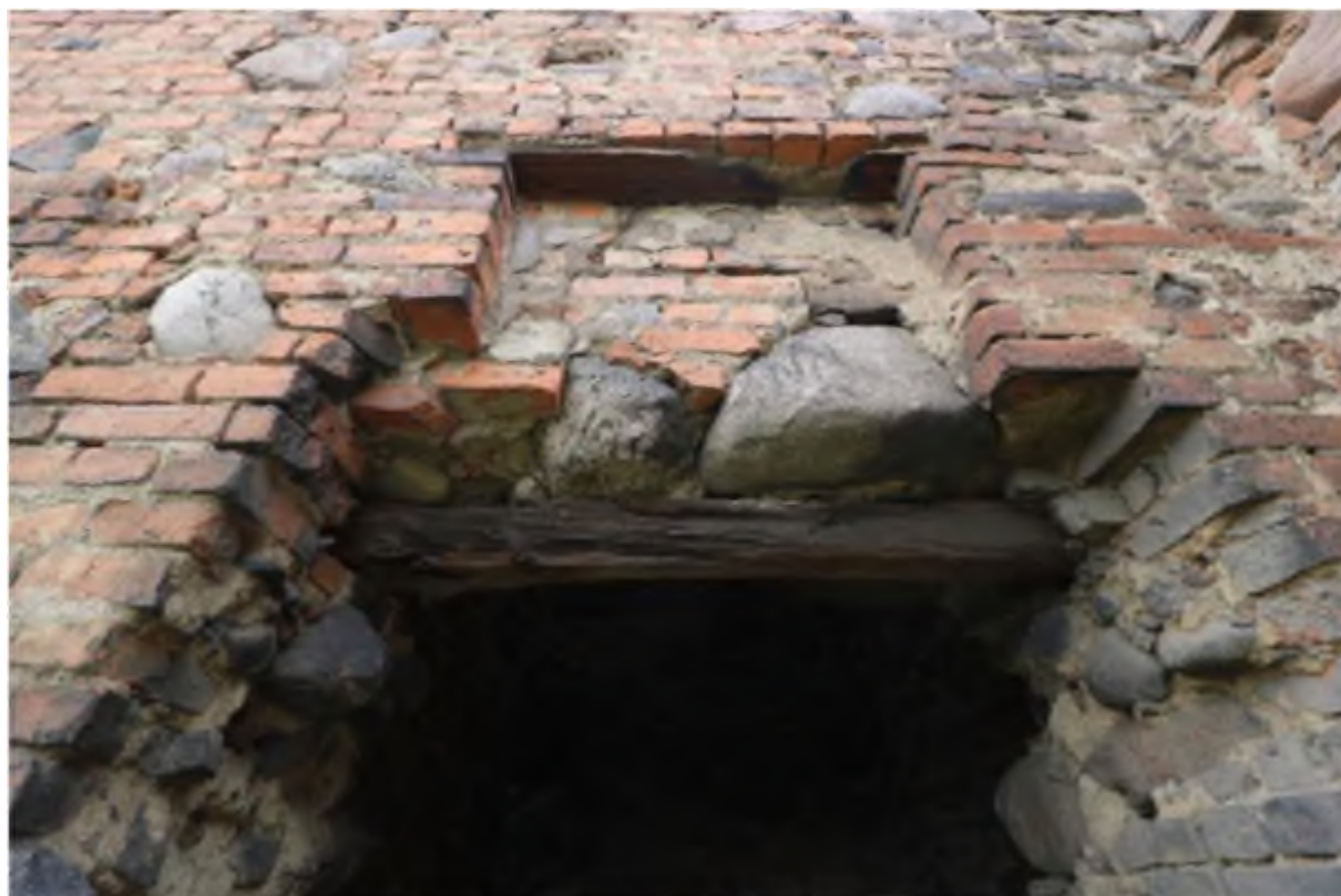
17. Wieża – ściana południowa – belka nadprożowa i wnęk na płytę inskrypcyjną
