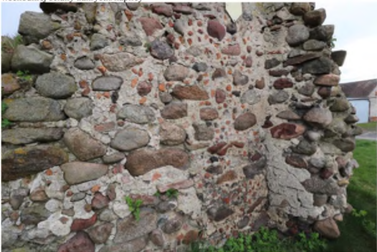
8 Północno-zachodni narożnik nawy – struktura spoinowania oraz pozostałości tynku
