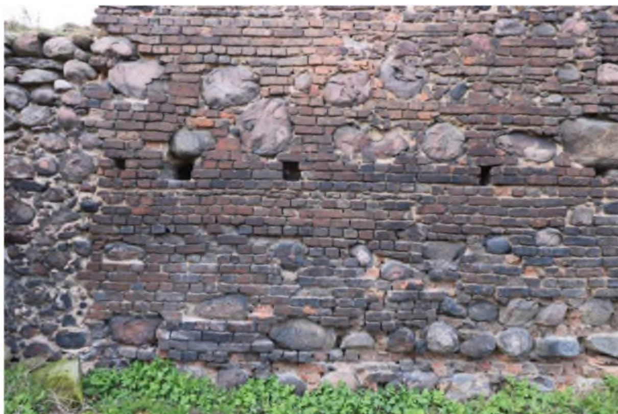
23. Wieża – elewacja wschodnia – otwory na belki podtrzymujące empore/chór
