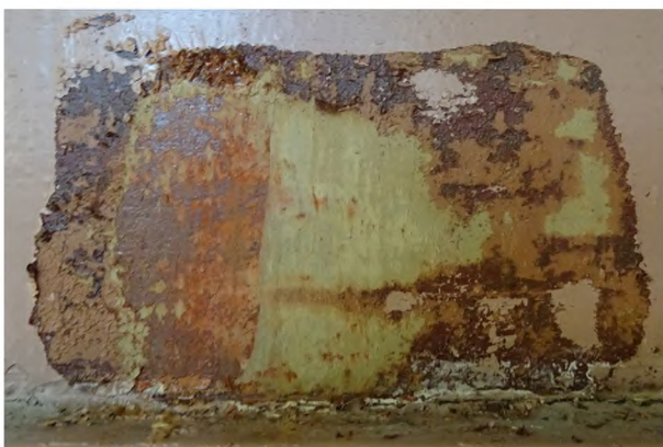
fot. 51: odkrywka na jednych z drzwi do południowej kruchty, od strony wnętrza kościoła; widoczna oranżowa malatura oraz kolejne, wtórne warstwy
