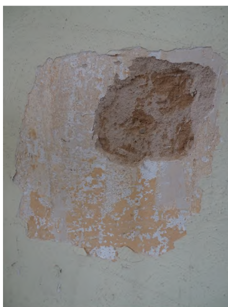
fot. 17: odkrywka na ścianie wschodniej na murze I fazy; widoczny pierwotny tynk bez zachowanej powierzchni, pod wtórną, odpowiadającą XVIIIw. tynkom wyprawą i młodszymi, wtórnymi malaturami
