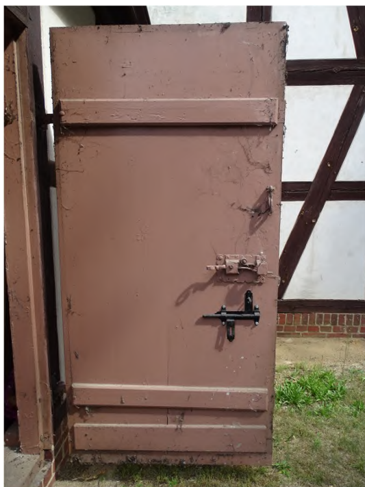
fot. 44: wewnętrzna strona drzwi do południowej kruchty; widoczny oryginalny zamek klamki, wtórna zasuwka i naprawka w dolnej partii
