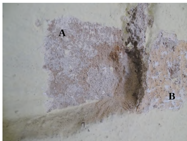
fot. 13: odkrywka warstw malarskich na tynku z 1699r. (A) i po prawej na tynku z okresu ostatniej rozbudowy około 1737r. (B), widoczne pozostawienie w początkowym etapie starszego z tynków bez opracowań pojawiających się na młodszej z wypraw
