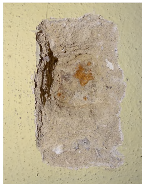
fot. 23: odkrywka w przestrzeni podwieżowej – d. kruchcie zachodniej, widoczny wtórny, współczesny tynk wapienno-cementowy w grubej warstwie i mur ceglany z patyną sugerującą pierwotne funkcjonowanie bez wyprawy tynkarskiej
