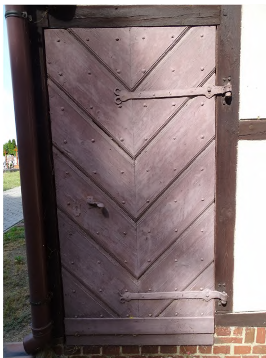
fot. 42: zewnętrzna strona drzwi do południowej kruchty; widoczna naprawka w dolnej partii
