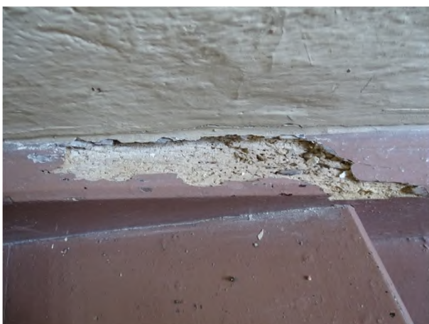
fot. 29: głęboka korozja biologiczna (spowodowana żerowaniem drewnojadów) przyściennego policzka schodów w kruchcie
