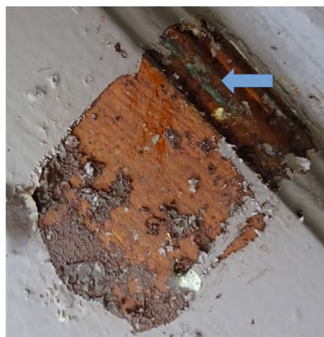
fot. 54: odkrywka drzwi do zakrystii z zewnątrz; widoczne ślady błękitno szarej malatury i warstwy wtórnych przemalowań
