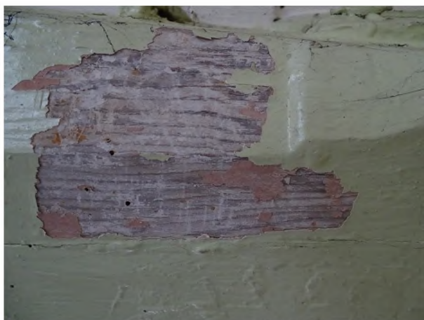
fot. 32: odkrywka na belce stropu nad emporą zachodnią; widoczne słabo zachowane ślady malowania w żółcieni na zaciosie i biel na płaszczyznach, na nich czerwień
