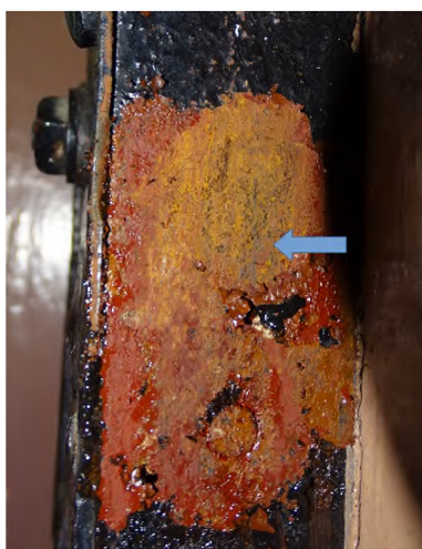
fot. 56: odkrywka na skrzynce zamka drzwi do zakrystii; widoczny ślad błękitno szarej malatury, następne warstwy różne od przemalowań stolarki
