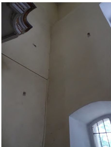
fot. 19: odkrywki w północno-wschodnim narożu korpusu; widoczne odkrywki ze śladem pierwotnej zaprawy jedynie w spoinach, opracowanie wyłącznie tynkiem współczesnym, wapienno-cementowym
