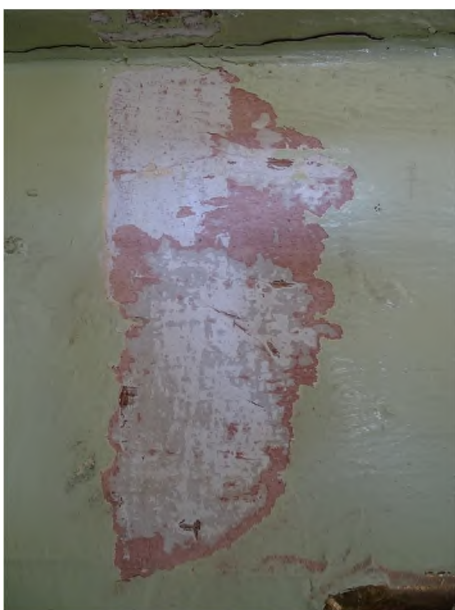
fot. 38: odkrywka malatur na ramie płyciny balustrady empor, widoczne malowanie w szarości na nim czerwień i kolejne wtórne warstwy
