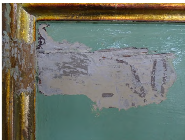
fot. 39: odkrywka malatur w polu i na profilu płyciny balustrady empor, widoczne malowania w bielach, we późniejszych, wtórnych warstwach w szarości z widocznym dekokrem a następnie żółcieni i obecnym seledynie; profil płyciny malowano jak profil poręczowy balustrady
