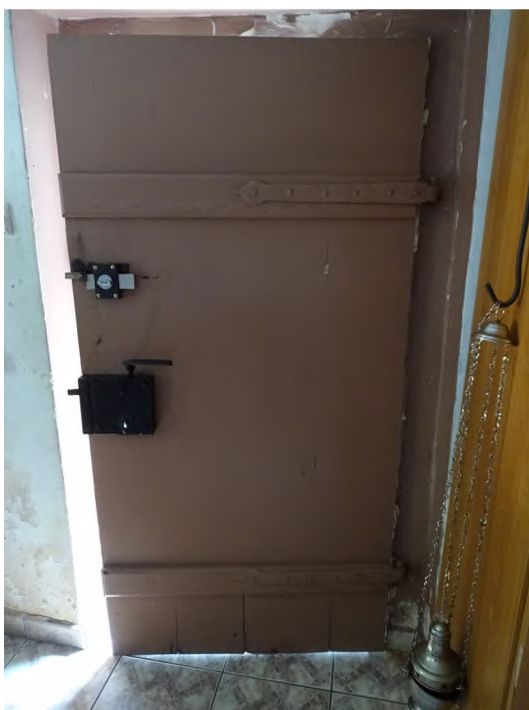
fot. 53: drzwi do zakrystii od wewnątrz; widoczny zachowany zamek skrzynkowy, zdublowany współczesnym zamkiem patentowym
