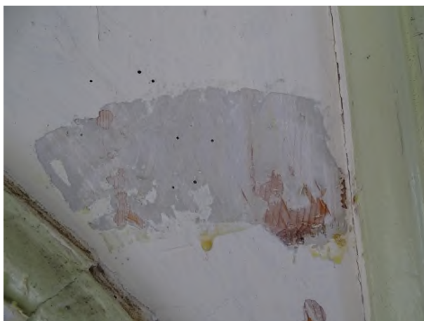
fot. 32: odkrywka na belce stropu nad emporą zachodnią; widoczne słabo zachowane ślady malowania w żółcieni na zaciosie i biel na płaszczyznach, na nich czerwień
