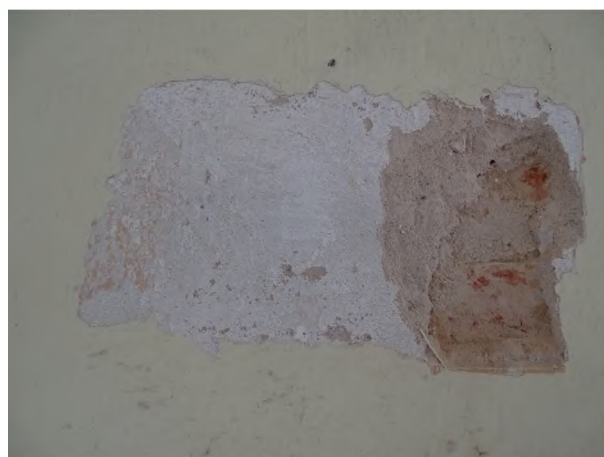
fot. 16: odkrywka na wschodniej ścianie kościoła na wysokości nadbudowy ponad murem I fazy; widoczny jedynie tynk III fazy (z XVIIIw. rozbudowy) i jego warstwy malarskie
