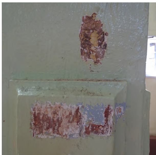
fot. 41: odkrywka na filarze i na jego płycinie w dolnej partii, w południowo-wschodniej części kościoła; widoczne ślady beli, a niej opracowanie w brązach odpowiadające zdobieniom na mieczach, wtórne przemalowanie w czerwieni i kolejne wtórne warstwy; na płycinie widoczna malatura farbą syntetyczną w błękitcie
