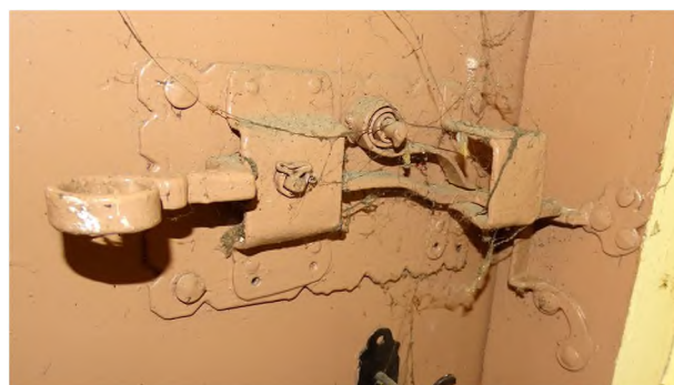
fot. 45: zachowany oryginalny zamek klamki drzwi do południowej kruchty
