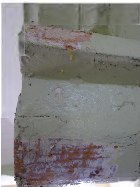
fot. 31: odkrywka na nosku arkad nad emporą zachodnią; widoczne słabo zachowane ślady malowania w żółceni, na nim czerwień
