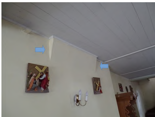
fot. 22: relikw pierwotnego muru ściany południowej sprzed XVIIIw. rozbudowy, zachowany na ścianie zachodniej pod emporą
