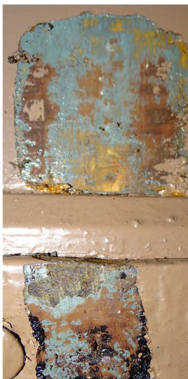
fot. 55: odkrywka drzwi do zakrystii od wewnątrz; widoczna błękitno szara malatura, jednakowo kładziona na stolarce jak i pasowym zawiasie, na niej warstwy wtórnych przemalowań
