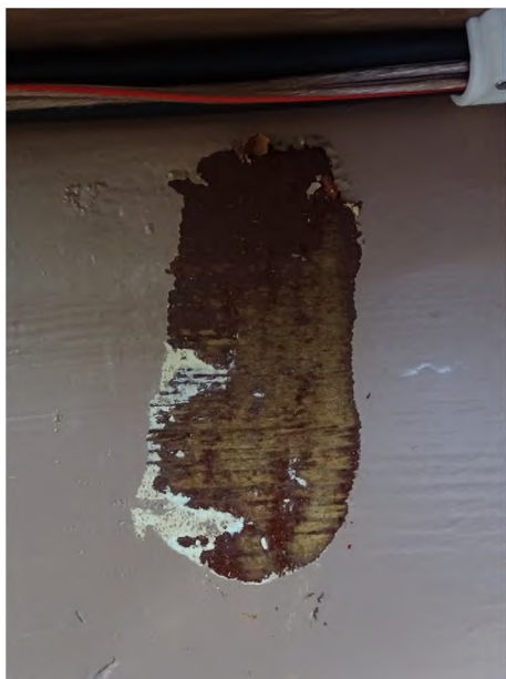
fot. 36: odkrywka na wewnętrznej powierzchni balustrady empor, widoczne jedynie wtórne malowania farbami syntetycznymi i patyna na drewnie
