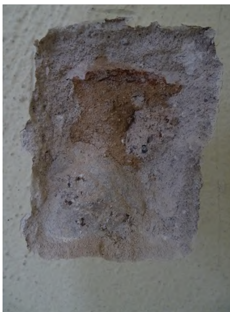
fot. 20: jedna z odkrywek w północno-wschodnim narożu korpusu; widoczny ślad pierwotnej zaprawy w spoinie i udział mieszanego budulca muru (kamiennie-ceglanego), obecne opracowanie wyłącznie tynkiem współczesnym, wapienno-cementowym
