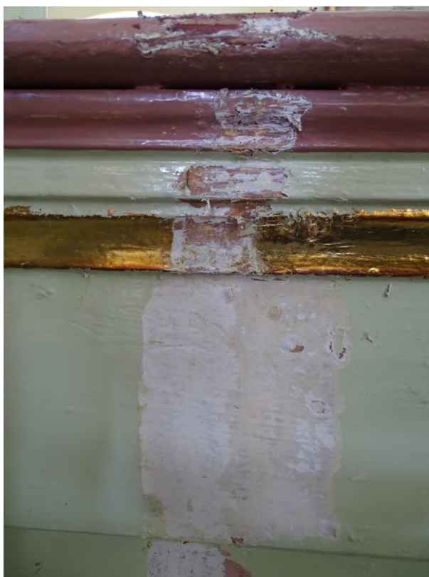
fot. 37: odkrywka na górnym profilu i belce balustrady empor; śladowo widoczne najstarsze malowania profilu w bieli i następne w żółceni, dobrze widoczne kolejne w czerwieni, późniejsze ze złoceniem szlagmetałem, częściowo przykrytym pod ostatnim malowaniem, w dolnej partii belka malowana początkowo głównie w bielach
