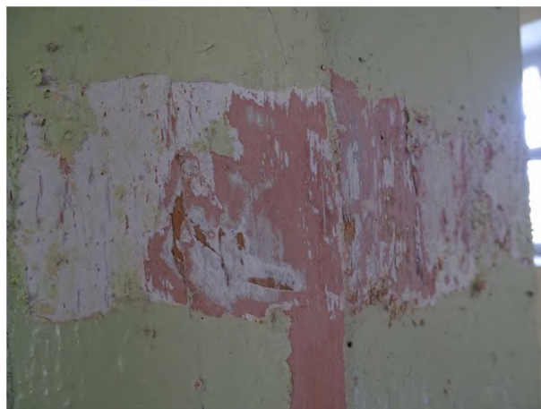
fot. 35: odkrywka malatur na filarze arkad nad emporą w górnej jego partii, widoczne malowanie w szarości na nim czerwień i kolejne wtórne warstwy
