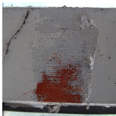
fot. 30: odkrywka warstw malarskich na stolarce okiennej, tu na oknie najwyższego rzędu w ścianie wschodniej widoczne opracowanie w czerwieni, następne w szarości i kolejne biele
