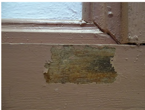
fot. 28: odkrywka na belce stropu w zachodniej kruchcie, widoczne ślady wskazujące na pierwotne opracowanie stolarki z pozostawieniem widocznej powierzchni drewna, ślady żółto-brązowego lakieru
