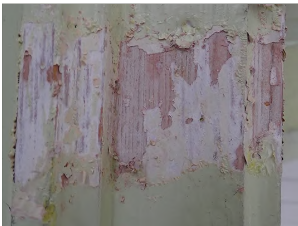
fot. 34: odkrywka malatur na łęku arkad nad emporą, widoczne malowanie w szarości na nim czerwień i kolejne wtórne warstwy
