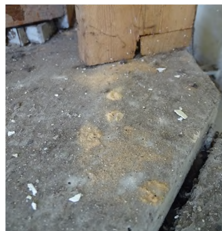
fot. 58: pył z otworów wylotowych drewnojadów na gzymsie ołtarza, świadczący o aktywnym żerowaniu owadów ciągle niszczących elementy drewniane we wnętrzu kościoła
