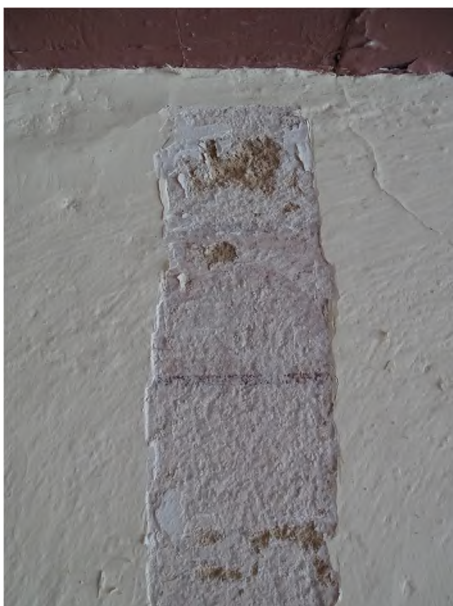
fot. 24: odkrywka wyprawy z lat 20. XXw. w zachodniej kruchcie z pierwszym jej opracowaniem malarskim w rozbielonym różu z odcięciem czarną linią pod stropem
