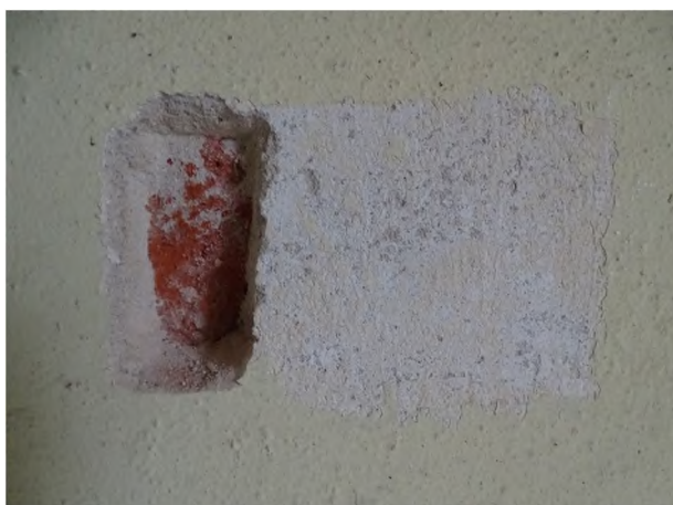
fot. 15: jedna z odkrywek w zachodniej części korpusu kościoła; widoczny współczesny tynk wapienno-cementowy bez zachowania starszych z wypraw
