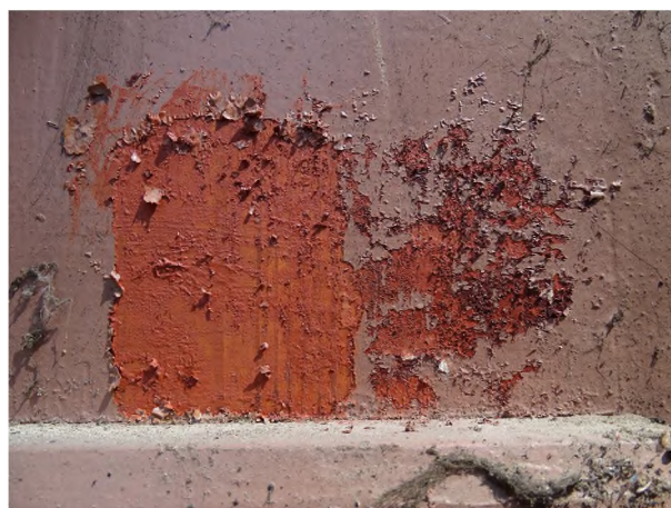
fot. 47: odkrywka warstw malarskich wewnętrznej strony drzwi do południowej kruchty; widoczne malowanie olejne w czerwieni i wtórne warstwy syntetyczne
