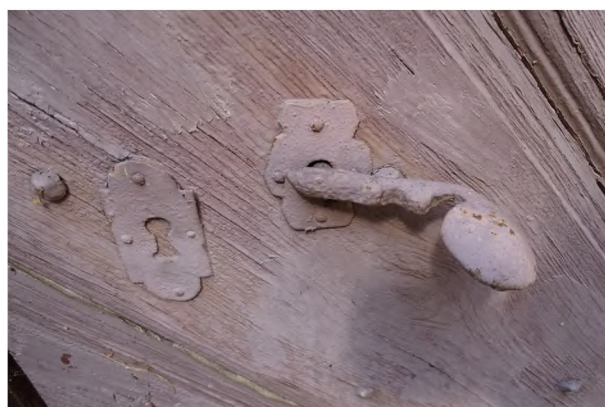
fot. 43: oryginalne klamka i ślepy szyld zamka drzwi do południowej kruchty; widoczne zwiertnienie drewna i tylko miejscowe zachowanie starszych z opracowań malarskich
