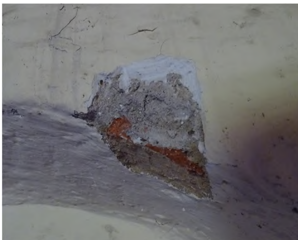
fot. 26: odkrywka na nadprożu przejścia z zachodniej kruchty do wieży, widoczny współczesny tynk cementowy
