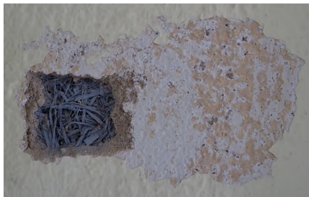
fot. 14: odkrywka wyprawy na murze ryglowym; widoczne współczesne pracowanie położone na supremie i pokrywające je kolejne warstwy malatur
