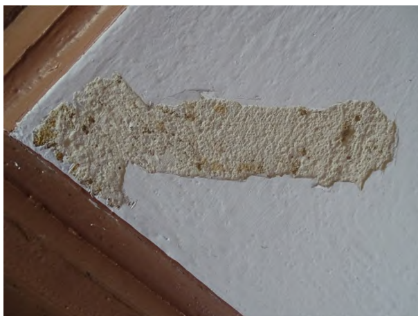
fot. 25: odkrywka na stropie z lat 20. XXw. w zachodniej kruchcie z pierwszym jego opracowaniem malarskim w rozbielonej żółci
