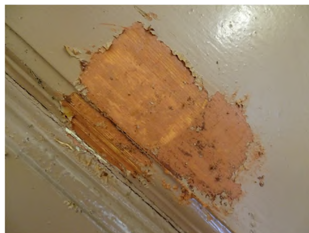
fot. 49: odkrywka na prawych z wewnętrznych drzwi do południowej kruchty; widoczna zachowana gładka powierzchnia drewna z najstarszym opracowaniem w oranżowym opracowaniu
