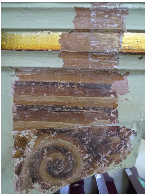
fot. 40: odkrywka malatur, tu na mieczu północnej balustrady empor i belce nad nim, widoczne iluzjonistyczne malowanie z imitacją woluty i profilowania na podkładzie rozbielonej żółcieni (pod spodem obecne starsze, monochromatyczne opracowanie); widoczna czerwień wtórnego przemalowania, obecna również w odkrywkach powyżej, na niej wtórne warstwy, ostatnia seledynowa przykrywa częściowo złocenie szlagmetalem
