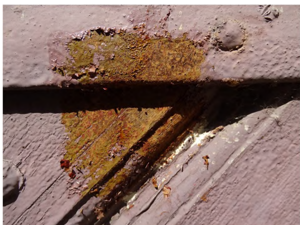
fot. 46: odkrywka warstw malarskich zewnętrznej strony drzwi do południowej kruchty; widoczne ślady olejnej czerwieni na drewnie i elementach metalowych oraz kolejne, wtórne warstwy
