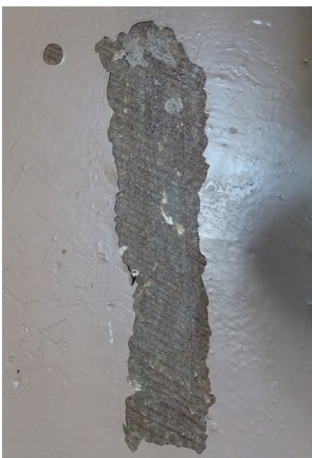
fot. 27: odkrywka na policzku schodów w zachodniej kruchcie, widoczne ślady zabrudzeń wskazujące na pierwotne opracowanie stolarki z pozostawieniem naturalnej powierzchni drewna, pod wtórnymi kryjącymi malowaniami ślady żółto-brązowego lakieru
