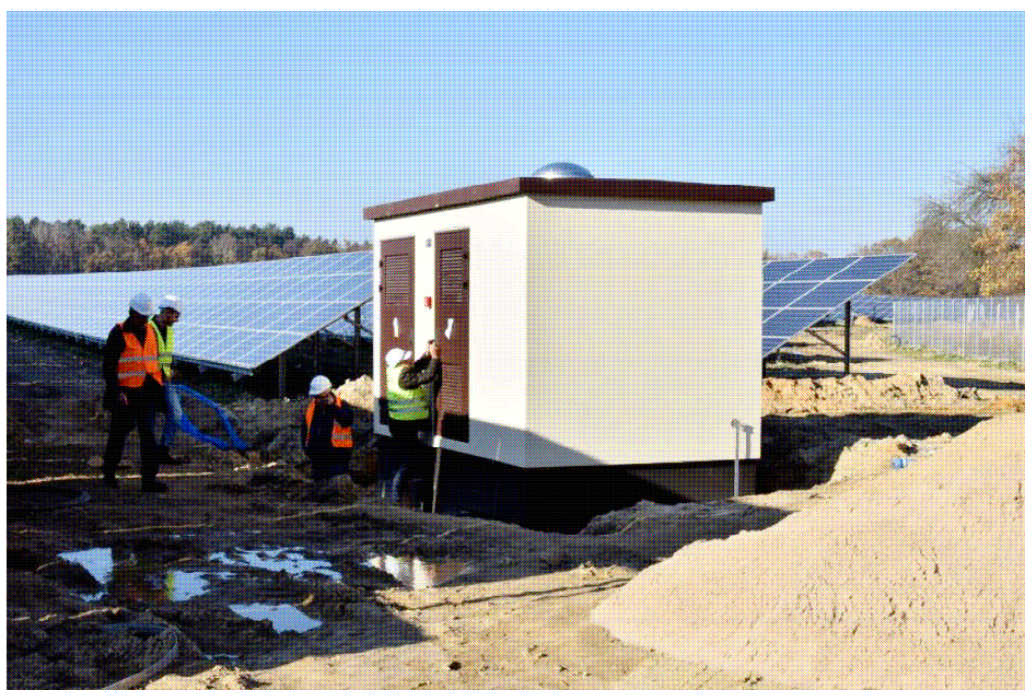
Rys. 12. Przykładowa kontenerowa stacja transformatorowa
