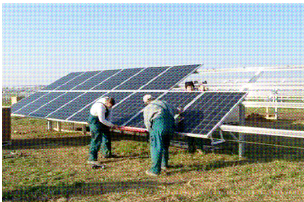
Rys 10. Montaż paneli
