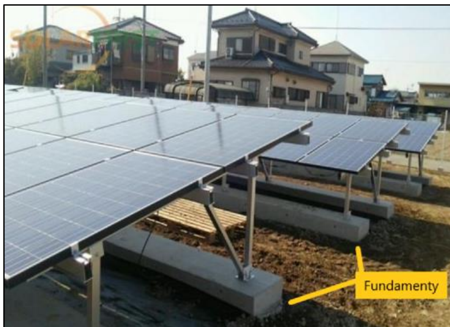
Ryc. 7 Montaż systemu nadążnego – prefabrykowane fundamenty.
