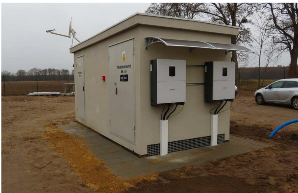
Ryc. 9 Przykładowa stacja transformatorowa z zainstalowanymi falownikami
