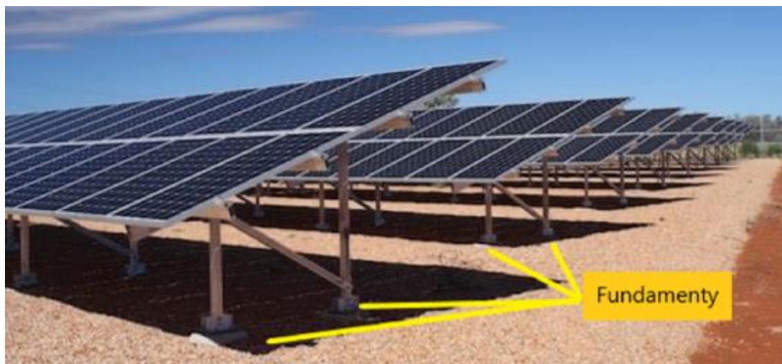
Ryc. 6 Montaż systemu nadążnego – wbicie w grunt.
