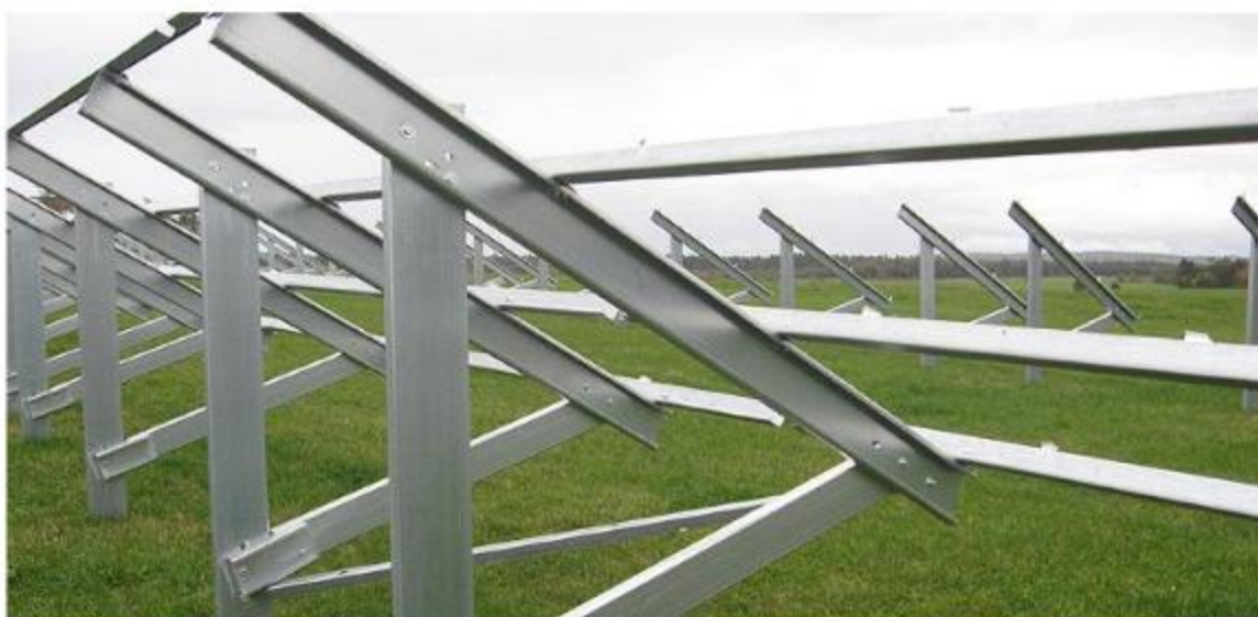
Fot. 4. Konstrukcja przeznaczona do posadowienia paneli fotowoltaicznych, (domena publiczna).
