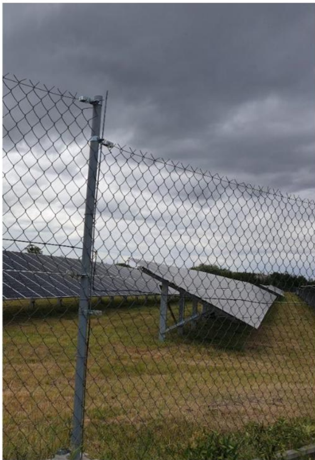
Fot. 3. Sposób montażu paneli fotowoltaicznych na stelażach wbijanych bezpośrednio do gruntu.
