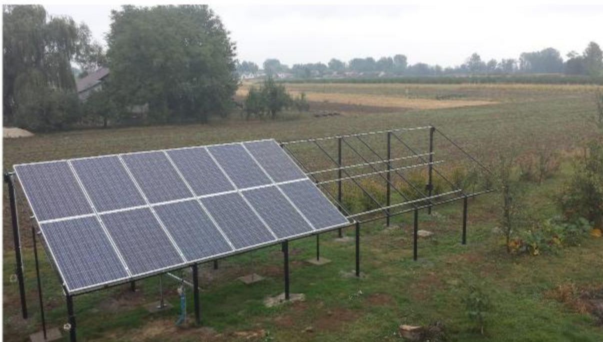
Fot. 1. Konstrukcja stołu z panelami fotowoltaicznymi, ( www.elektroda.pl ).
